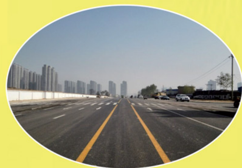
西外环西延道路工程
