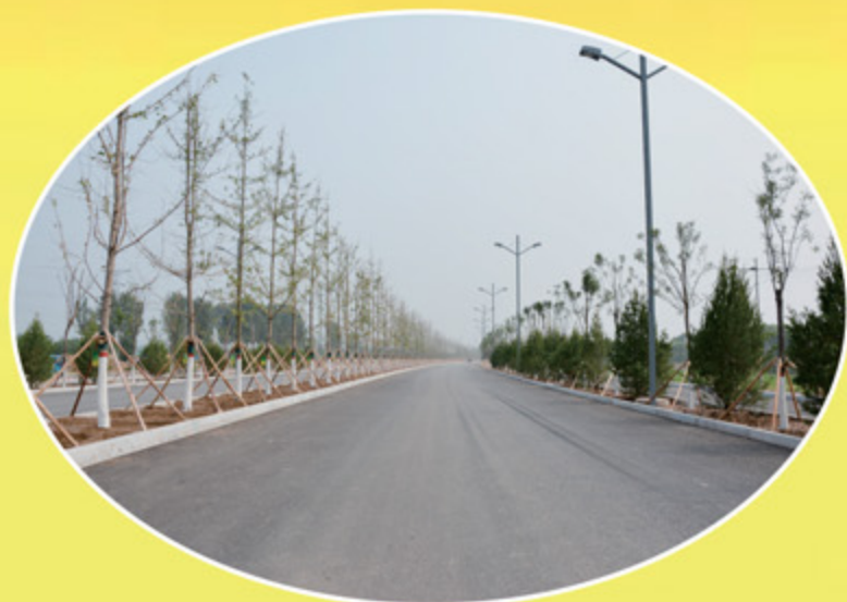
滨河西路南延道路工程
