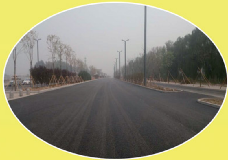
太茅路道路工程
