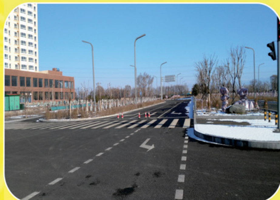
忻州雁门大道道路工程
