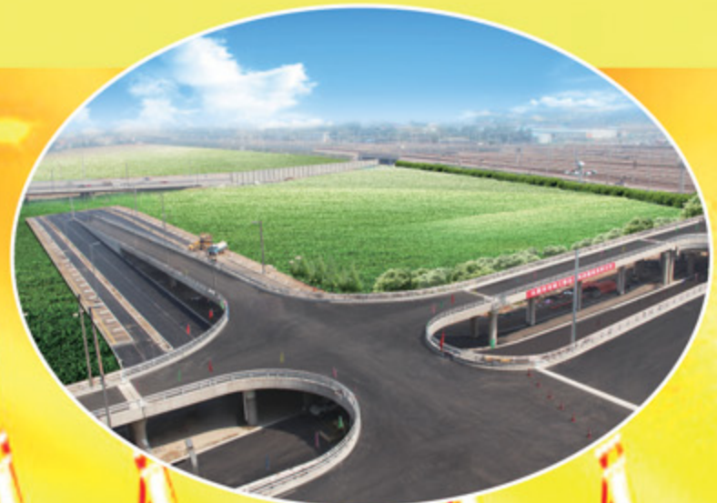
太原南站车站北路道路工程
